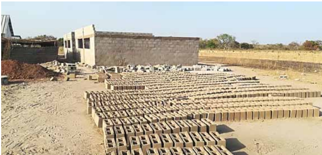
Con los bloques de hormigón elaborados se construyen escuelas, principalmente
