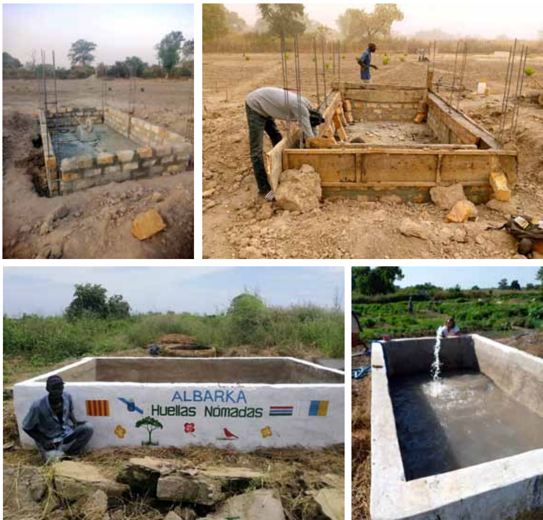
Construcción de una balsa de agua en Sololo para el riego del huerto de grandes extensiones
