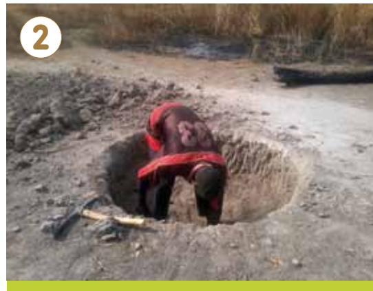
Inicio de la construcción
