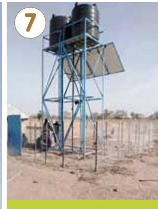
Vallado de protección
