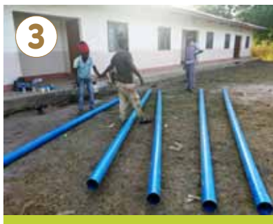
Colocación de tuberías y griferías
