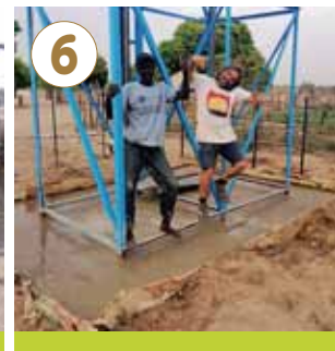
Cementación de la estructura
