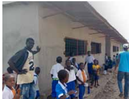
Así van las obras de la nueva escuela
