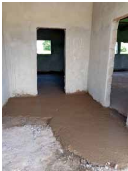
Distintas fases de la rehabilitación y reconstrucción de la Escuela de Sare Nalen
