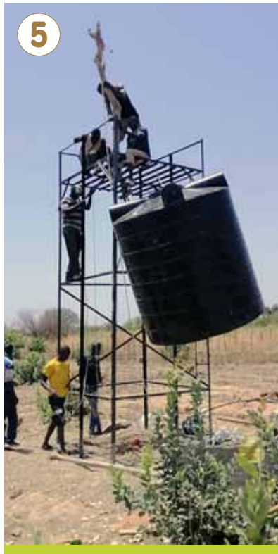
Colocación de los depósitos de agua
