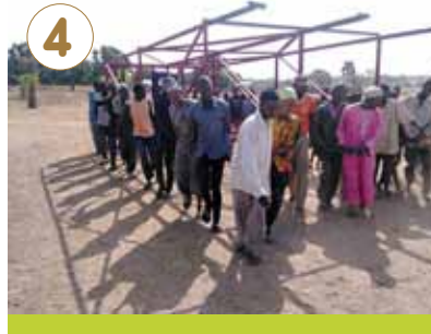
Colocación de la estructura
