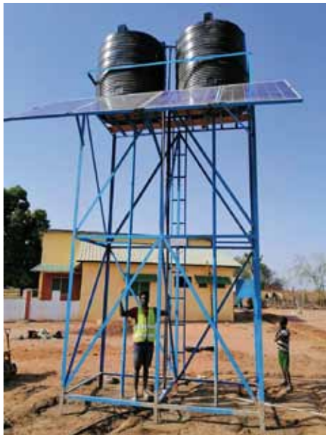
Pozo con Bomba Solar construido durante este año
