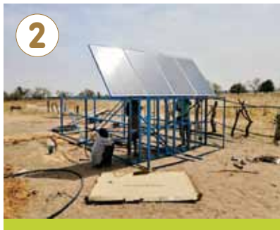
Soldadura e instalación de placas solares
