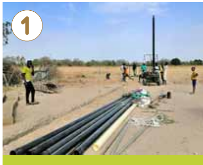
Perforación del pozo y colocación bomba solar
