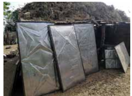
Las nuevas ventanas a punto de ser colocadas
