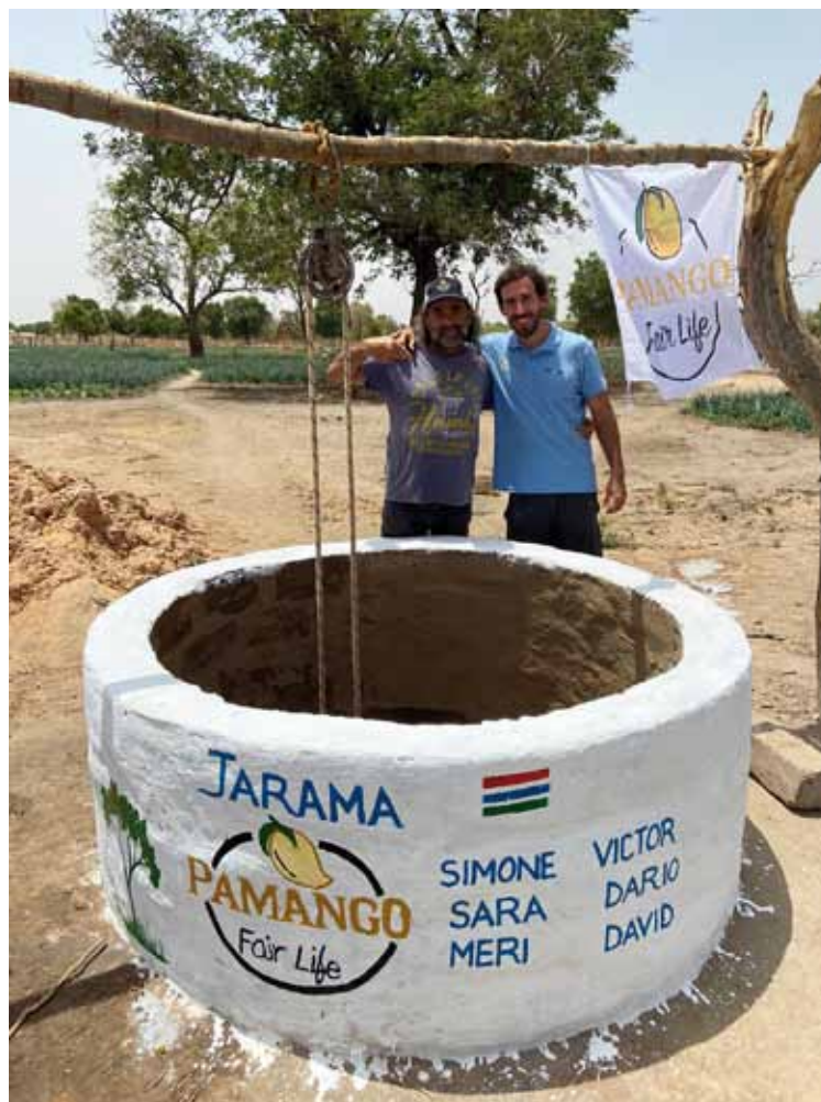
Uno de los pozos que se han podido construir gracias a la ayuda de la ONG Pamango Fair-Life
